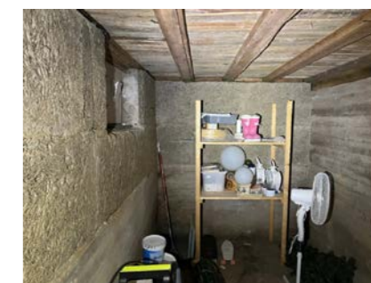
Uinnredet bod med Tresonitt plater på vegger.
