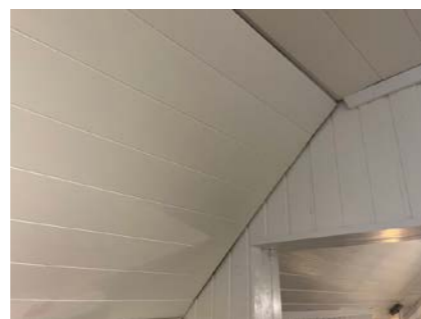
Gjenstående arbeider i loftetasje.
