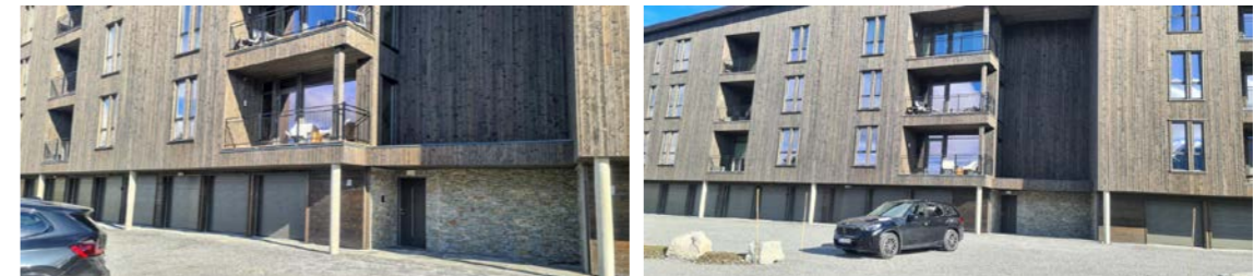
Bilde av inngang i kjeller g opp til venstre ligger leiligheten.
