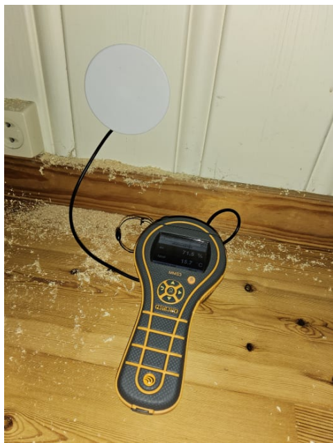
Bilde viser fuktmåling.
