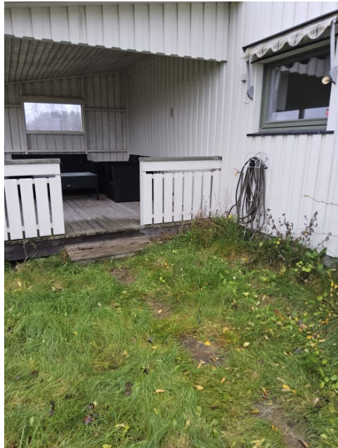
Bilde viser grunnmur skjult bak terrasse.
