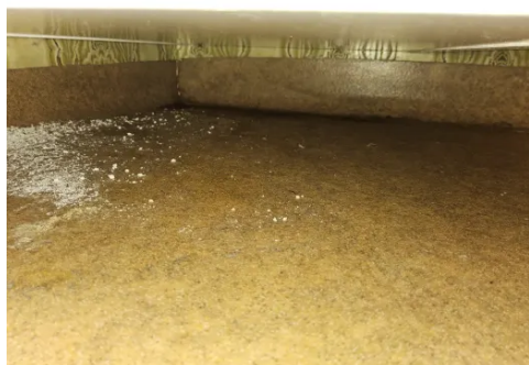
Bilde viser utettheter i tettesjiktet.
