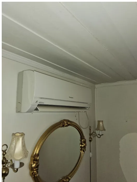
Bilde viser varmepumpe.
