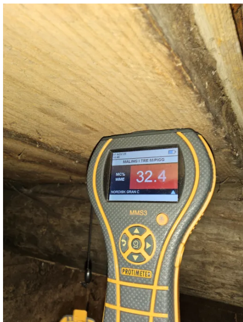
Bilde viser fuktmåling i kjeller.
