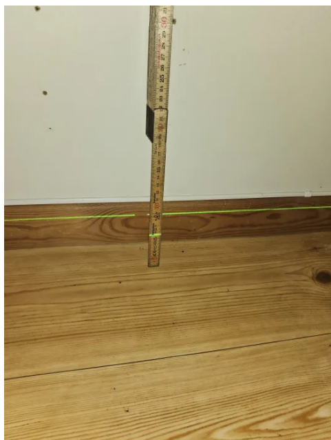
Bilde viser måling av etasjeskiller.
