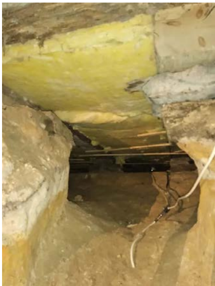
Bilde viser krypkjeller.
