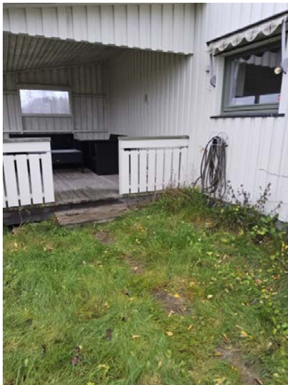
Bilde viser grunnmur skjult bak terrasse.
