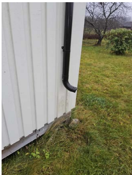
Bilde viser nedløpsrør avsluttet over bakken.
