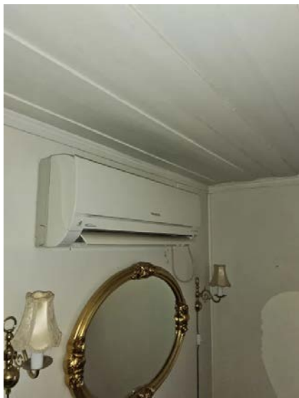
Bilde viser varmepumpe.
