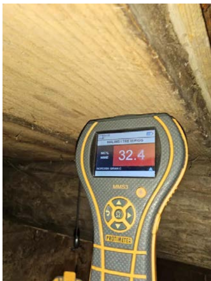
Bilde viser fuktmåling i kjeller.
