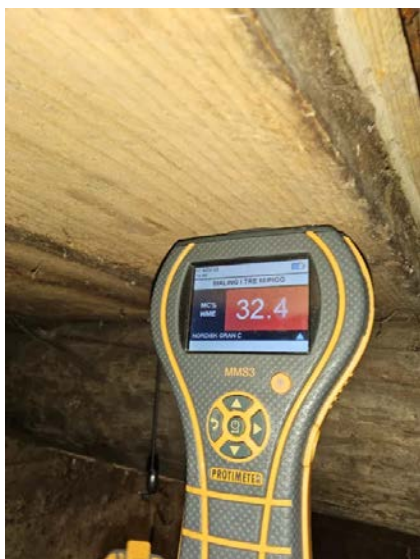
Bilde viser fuktmåling i kjeller.
