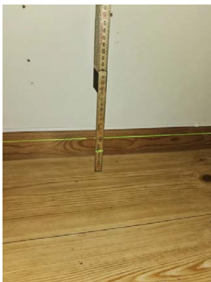
Bilde viser måling av etasjeskiller.
