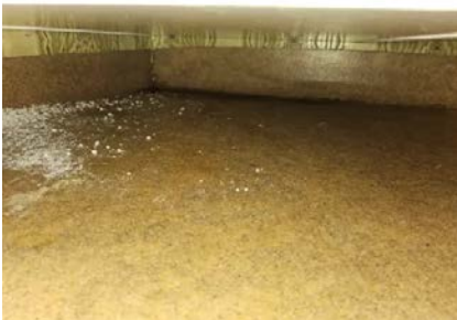
Bilde viser utettheter i tettesjiktet.
