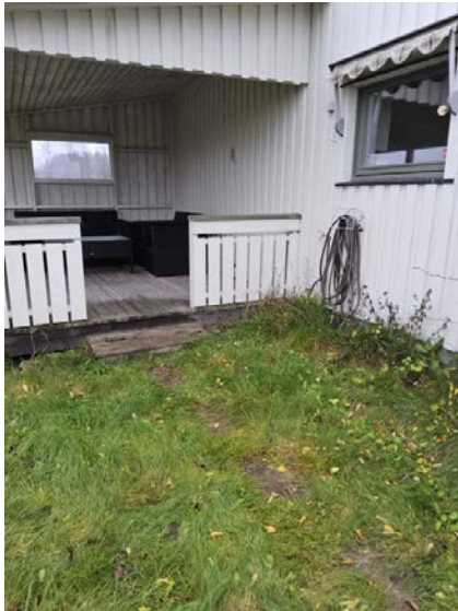
Bilde viser grunnmur skjult bak terrasse.
