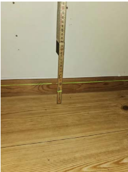
Bilde viser måling av etasjeskiller.
