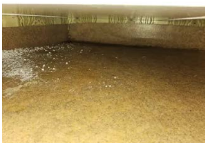
Bilde viser utettheter i tettesjiktet.
