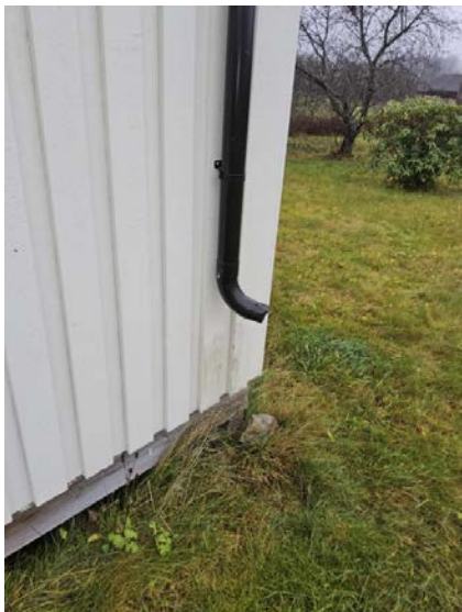
Bilde viser nedløpsrør avsluttet over bakken.
