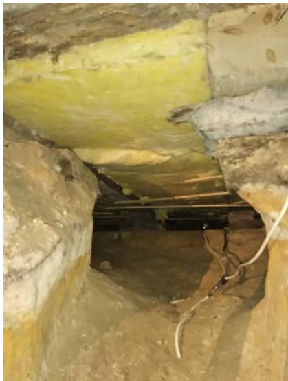
Bilde viser krypkjeller.
