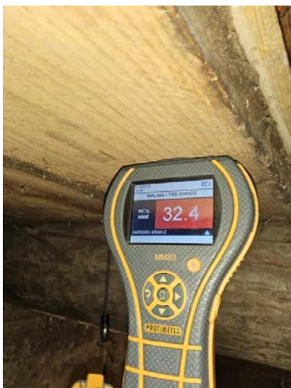
Bilde viser fuktmåling i kjeller.
