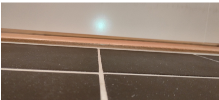
Kontroll av høyde på luftespalte under døren.
