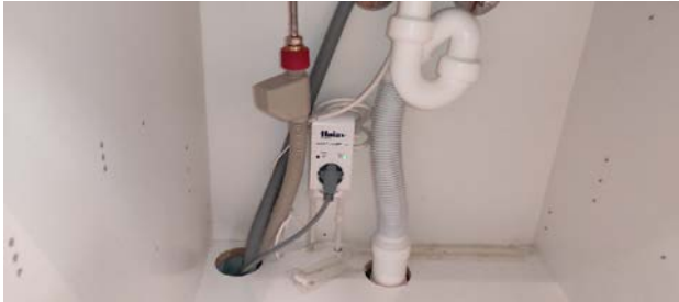
Kontroll av røropplegg.
