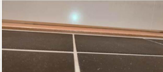
Kontroll av høyde på luftespalte under døren.
