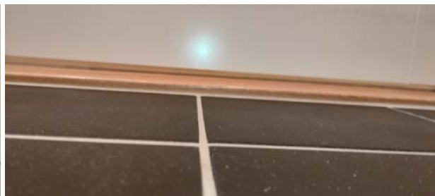
Kontroll av høyde på luftespalte under døren.
