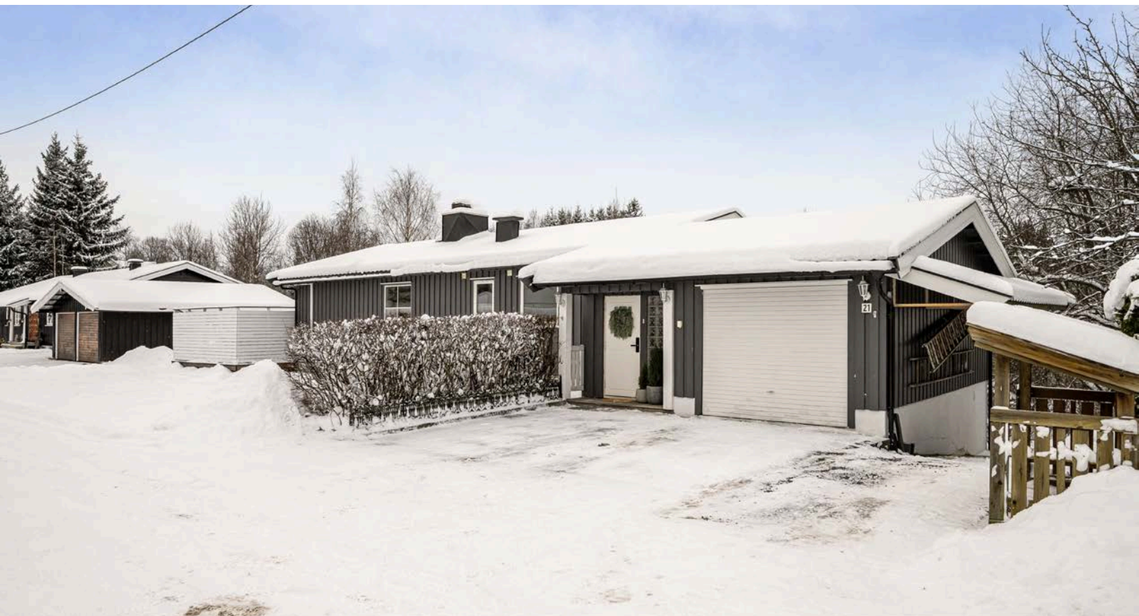
Boligen har inntilbygget garasje. Montert elbil-lader på yttervegg ved inntilbygget garasje. Eiendommen er også bebygd med en garasje på 23m 2 (halvpart av dobbeltgarasje som deles med naboen).
