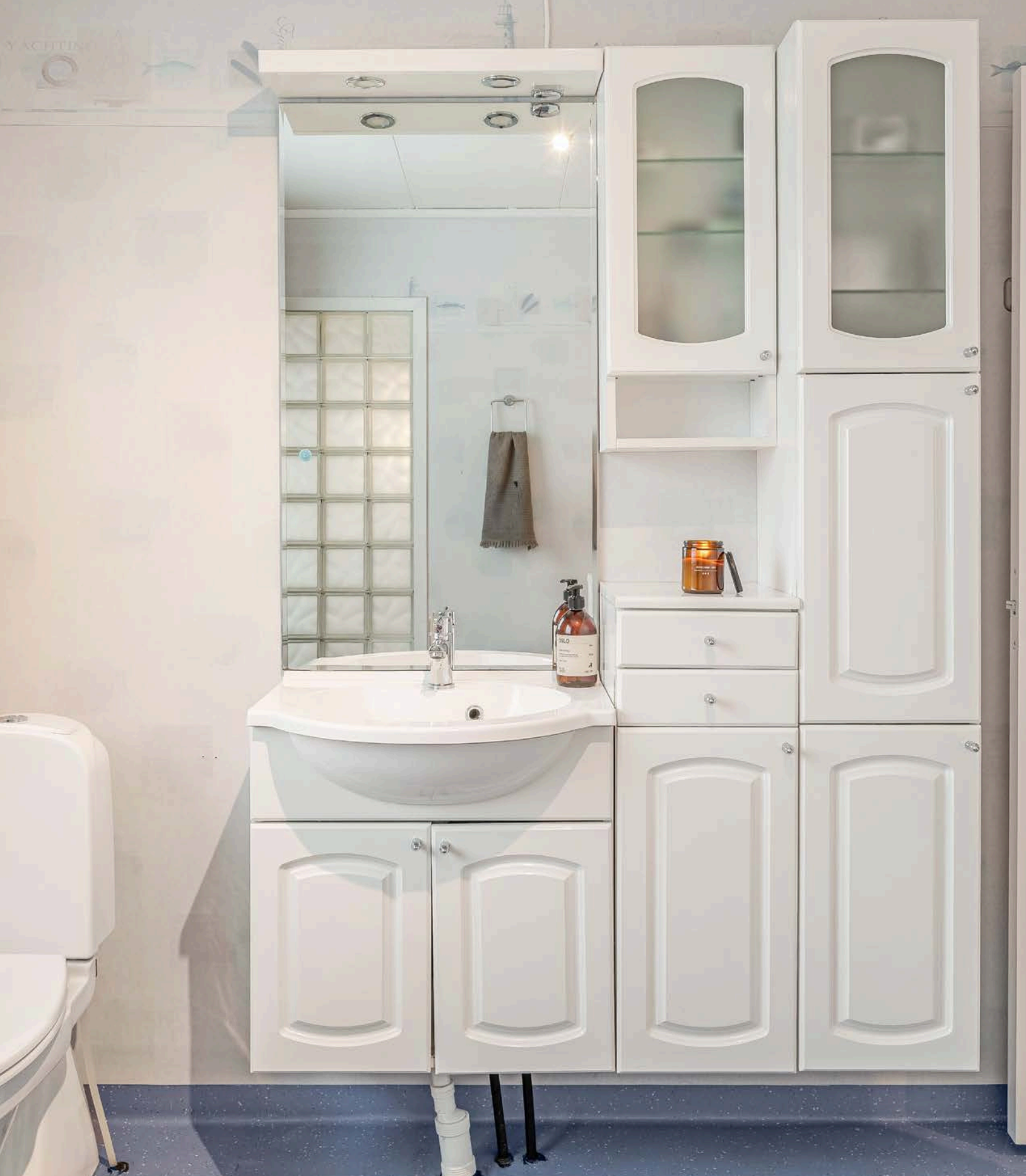
Lyst baderom i 1. etasje med overflater, installasjoner og komponenter fra ca. 2009. Baderommet har våtromsbelegg på gulv, overflater med vinylbelegg og elektrisk styrt vifte.
