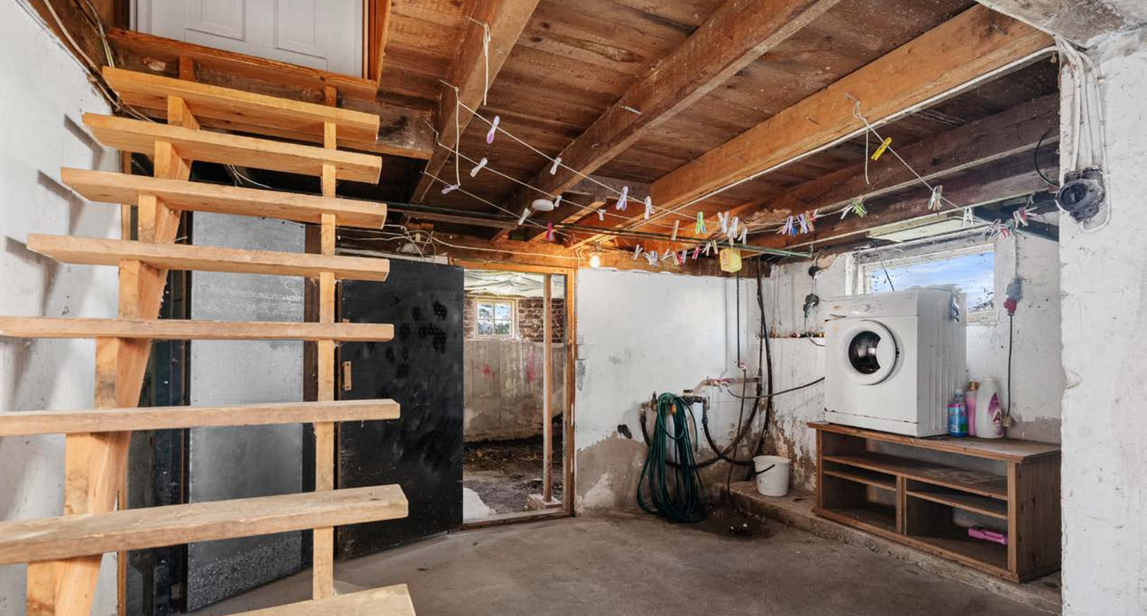
Kjeller: Kjellerentre/vaskerom, teknisk rom, uinnredet rom Vaskekjeller
