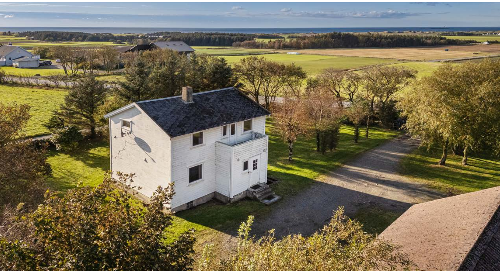
Boligen er av eldre dato og renovering må påregnes.
