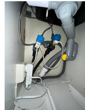
Rørproppleg i kjøkkenbenk med Waterguard
