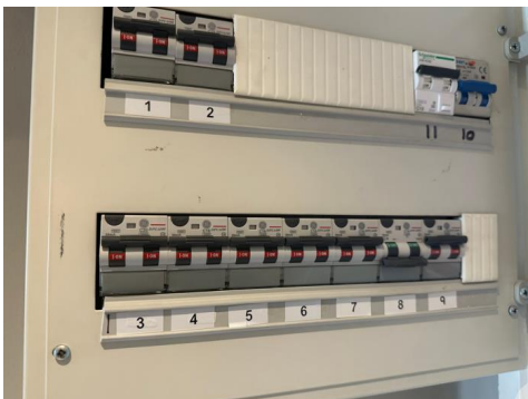
Sikringsskap med automatsikringer.
