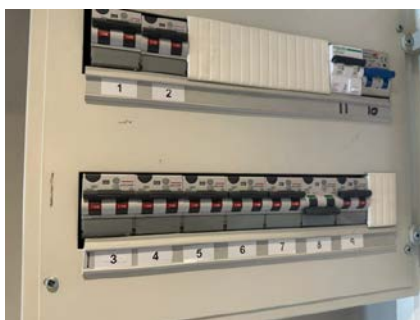
Sikringsskap med automatsikringer.
