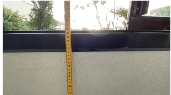
Rekkverk med balkongkasse har en høyde på 77 cm
