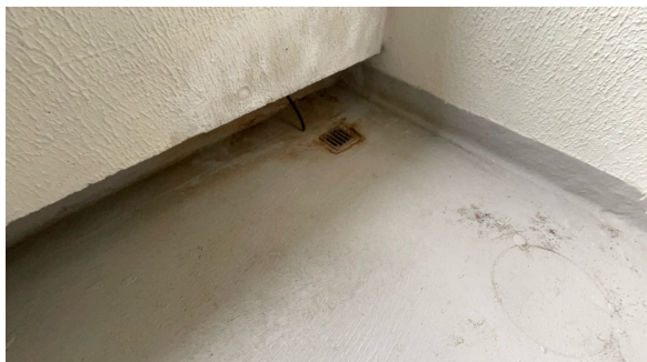
Balkong har sluk i hjørnet.
