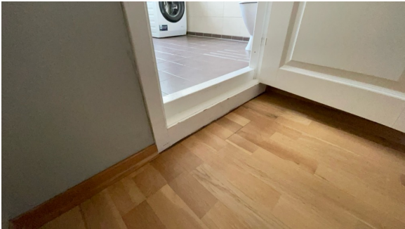
Terskell til bad har høyde 14 cm. Lysåpning / fri bredde på dør til bad er 57 cm
