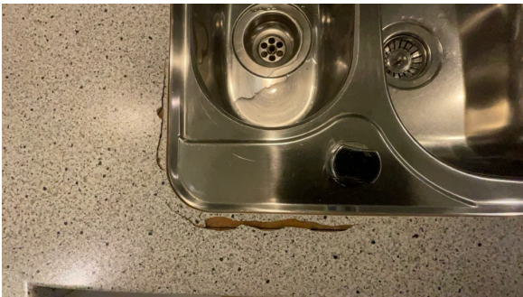
Benkeplate har stor skade ved underlimet vask.
