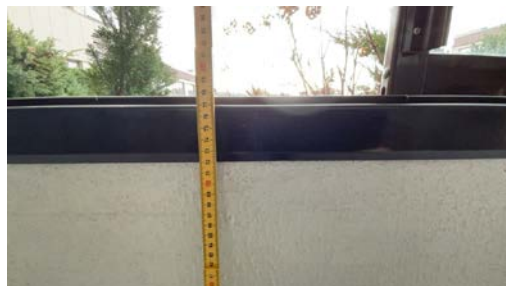
Rekkverk med balkongkasse har en høyde på 77 cm
