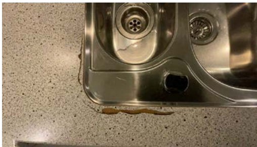
Benkeplate har stor skade ved underlimet vask.
