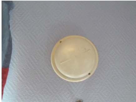
Ventil i ytterveggen.
