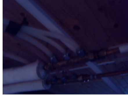
Åpne koblinger. (ingen fordelerskap)
