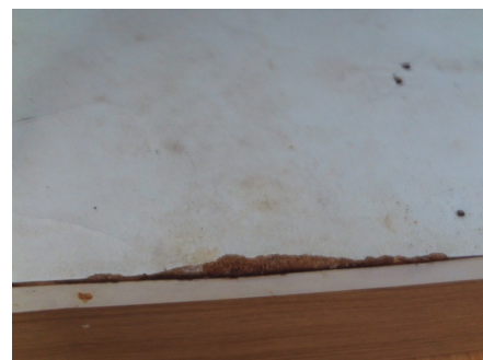
Bunnplate har svellet noe under vasken.
