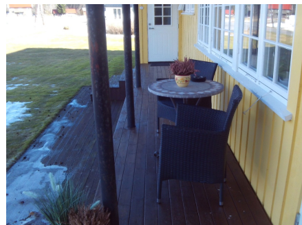
Overbygget svalgang ved inngangsparti
