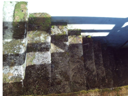
Eldre utvendig støpt kjellertrapp.
