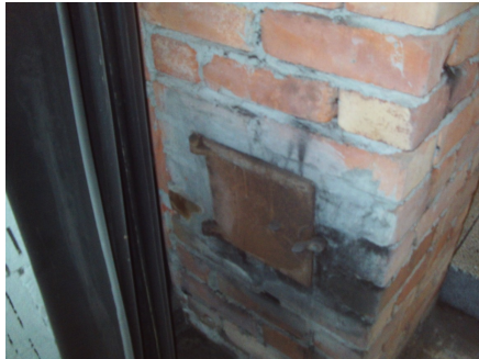
Sotluke i grovkjeller.
