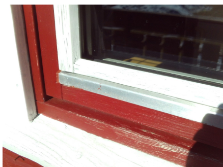
Vinduer har kun normal slitasje utvendig
