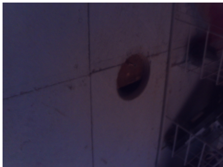
Hulltaking fra trapperom til kjeller.
