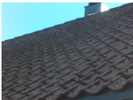
Eldre takstein i fra byggeåret.
