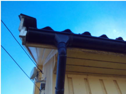
Takrenner har blitt byttet
