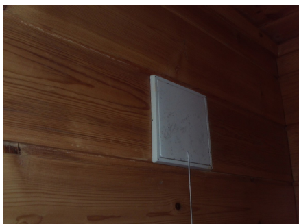
Ventil i ytterveggen.
