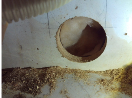
Hulltaking i fra benkeskap på kjøkken.
