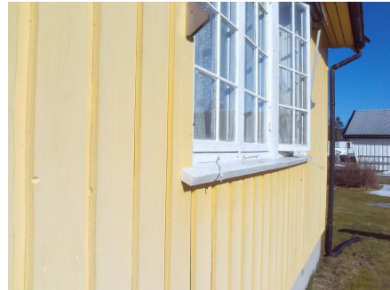
Deler av kledningen med tilhørende belistninger.
