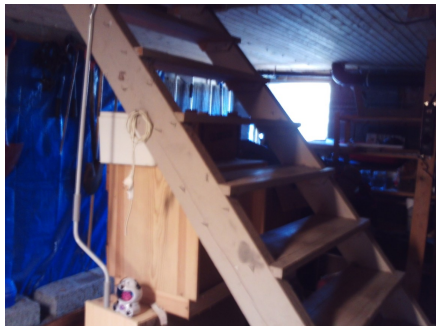
Kjellertrappen tilfredstiller ikke krav med tanke på sikkerhet.
