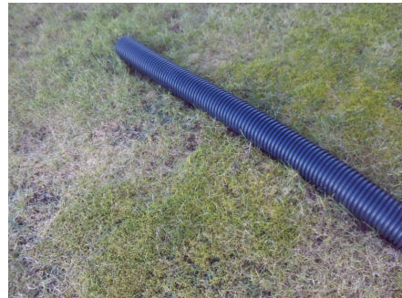
Taknedløp er ledet bort fra grunnmur.
