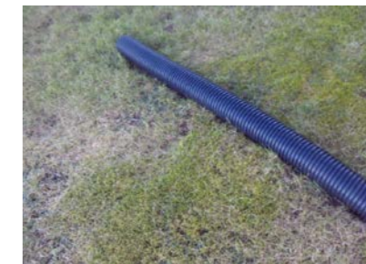
Taknedløp er ledet bort fra grunnmur.
