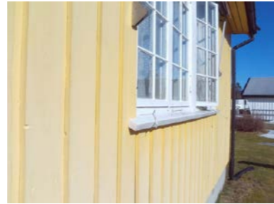
Deler av kledningen med tilhørende belistninger.
