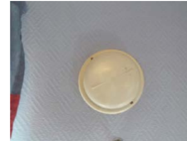
Ventil i ytterveggen.
