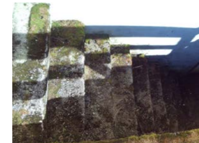
Eldre utvendig støpt kjellertrapp.
