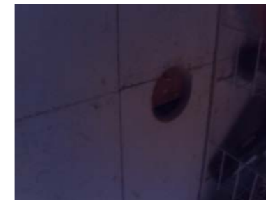
Hulltaking fra trapperom til kjeller.
