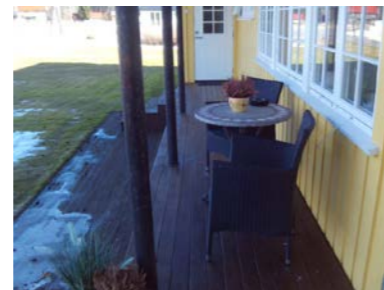
Overbygget svalgang ved inngangsparti
