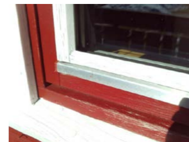
Vinduer har kun normal slitasje utvendig
