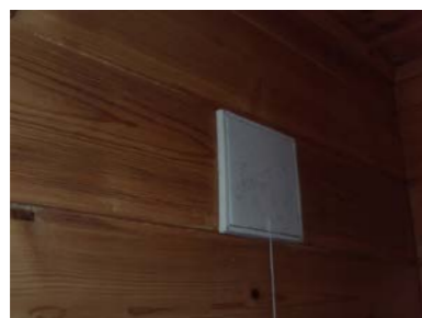
Ventil i ytterveggen.
