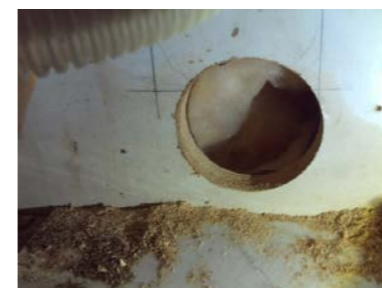
Hulltaking i fra benkeskap på kjøkken.
