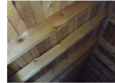
Deler av takkonstruksjonen.
