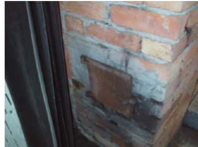
Sotluke i grovkjeller.
