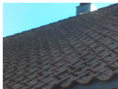
Eldre takstein i fra byggeåret.
