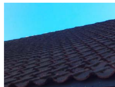
Deler av taktekkingen.
