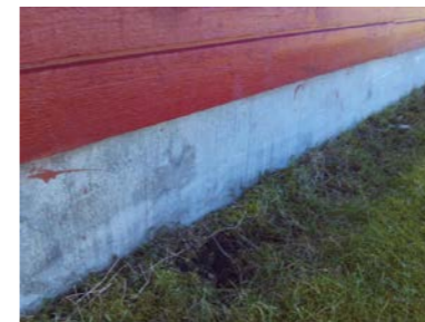
Deler av ringmuren.
