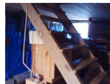
Kjellertrappen tilfredstiller ikke krav med tanke på sikkerhet.
