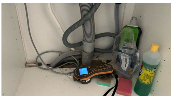
Ingen fuktighet registrert ved fuktsøk
