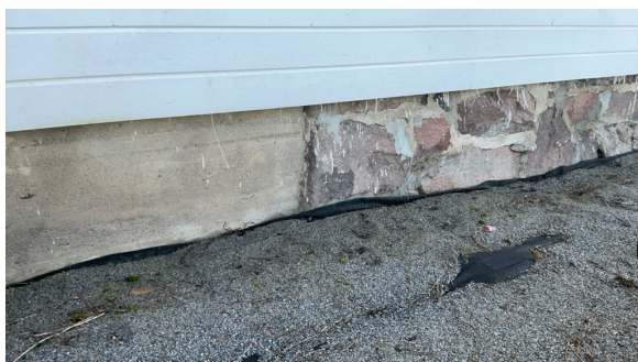
Skille mellom betongmur og gråsteinsmur
