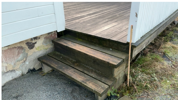
Manglende rekkverk
