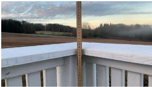
Lavt rekkverk
