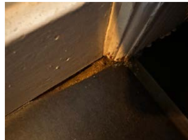
Flis som mangler litt av hjørnet
