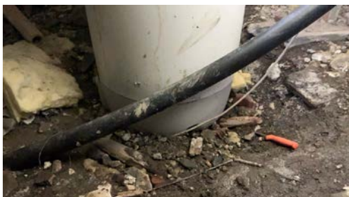
Bereider står ned på terrenget
