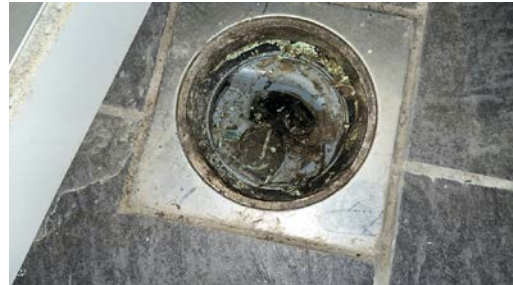
Sluk under dusjkabinett
