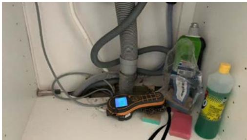
Ingen fuktighet registrert ved fuktsøk
