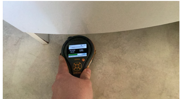
Ved bruk av fuktindikator registrerte jeg ingen unormale verdier.
