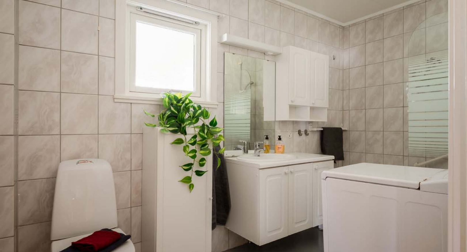
Bad med epoxy på gulv og fliser på veggene.
