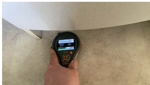
Ved bruk av fuktindikator registrerte jeg ingen unormale verdier.
