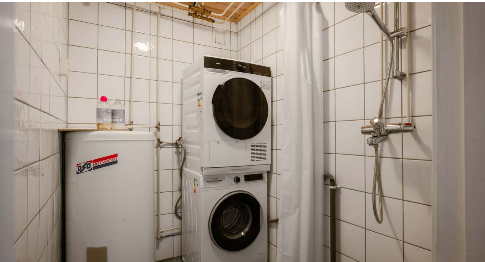
Vaskerom med dusj i underetasjen på Veldromsenga 7B.
