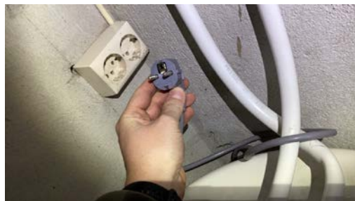
Sjekk av støpsele på bereder i opprinnelig del.
