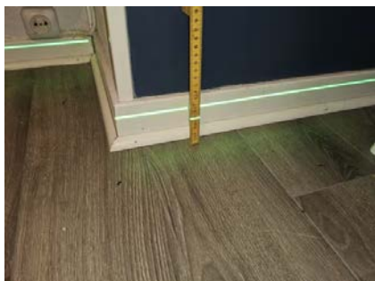
Etasjeskillet er kontrollert med nivelleringslaser.
