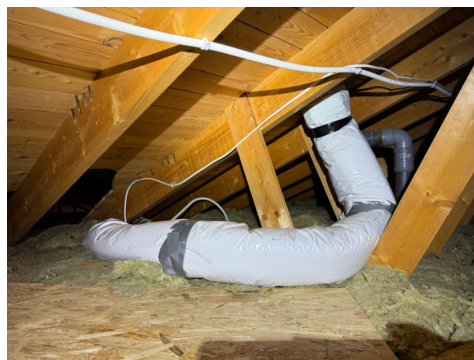
Nytt ventilasjonsrør fra bad
