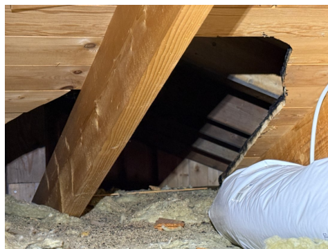
Området over overbygget trapp er ikke besiktiget.
