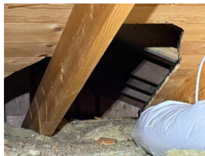
Området over overbygget trapp er ikke besiktiget.
