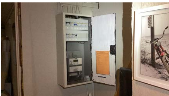
TG 0 Utstyr for varsling og slukking av brann
