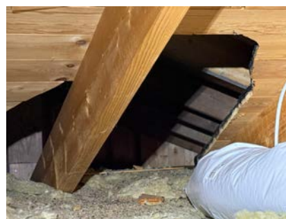
Området over overbygget trapp er ikke besiktiget.
