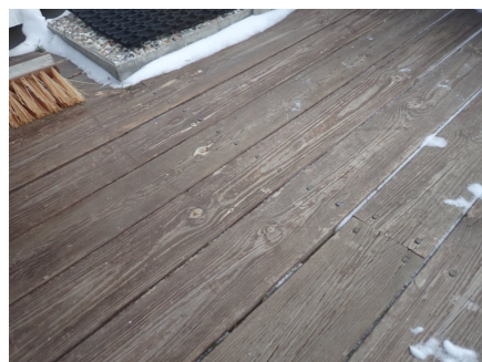
Noe slitasje og spikerhoder på vei opp.
