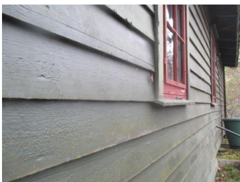
Deler av kledningen med tilhørende belistninger.
