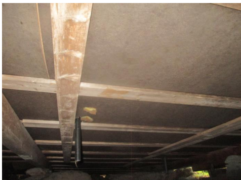
Pilarer har kantet under drager på midten av hytta.
