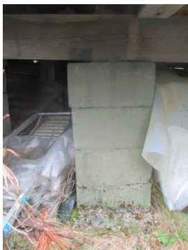
Pilarer har kantet under drager på midten av hytta.
