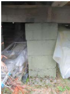
Pilarer har kantet under dragar på midten av hytta.
