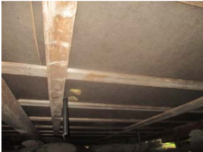
Pilarer har kantet under dragar på midten av hytta.
