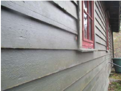
Deler av kledningen med tilhørende belistninger.
