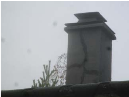
Sprekker i pipe over tak som er fuget igjen.
