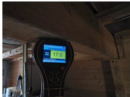
Drager på mot mot nord
