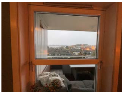
Originalt vindu på kjøkkenet er godt beskyttet for vær og vind.
