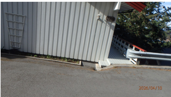
Bilde viser fall mot mur.
