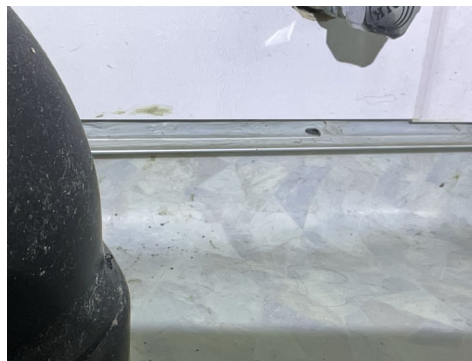
Åpent eksponert treverk i nedre del av vegg mellom bad og toalettrom.
