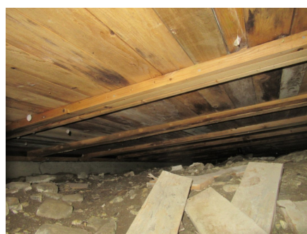
Krypkjeller under bjelkelag fotografert via ventil
