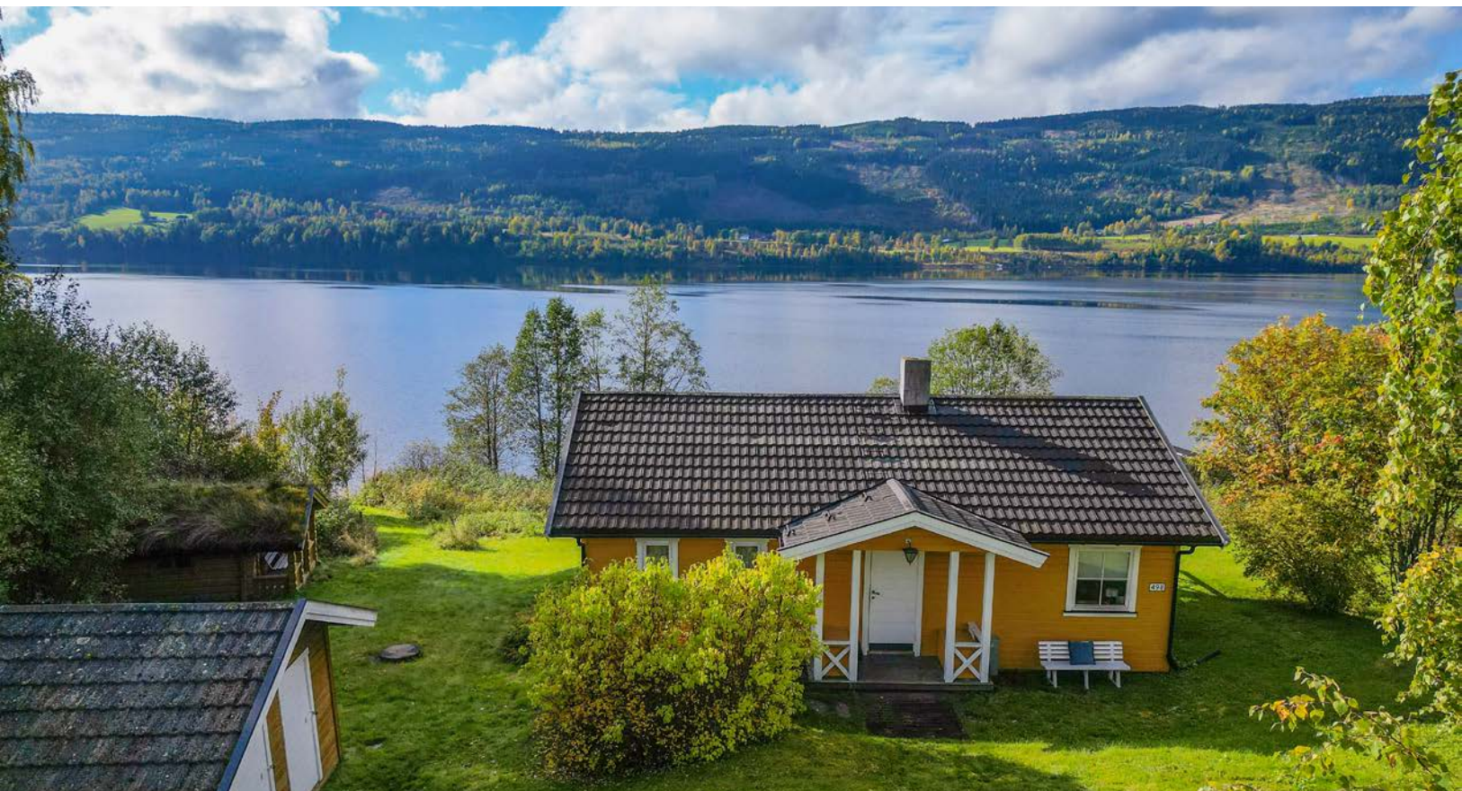
Uthus på eiendommen.
