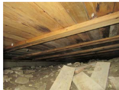
Kryp Kjeller under bjelkelag fotografert via ventil
