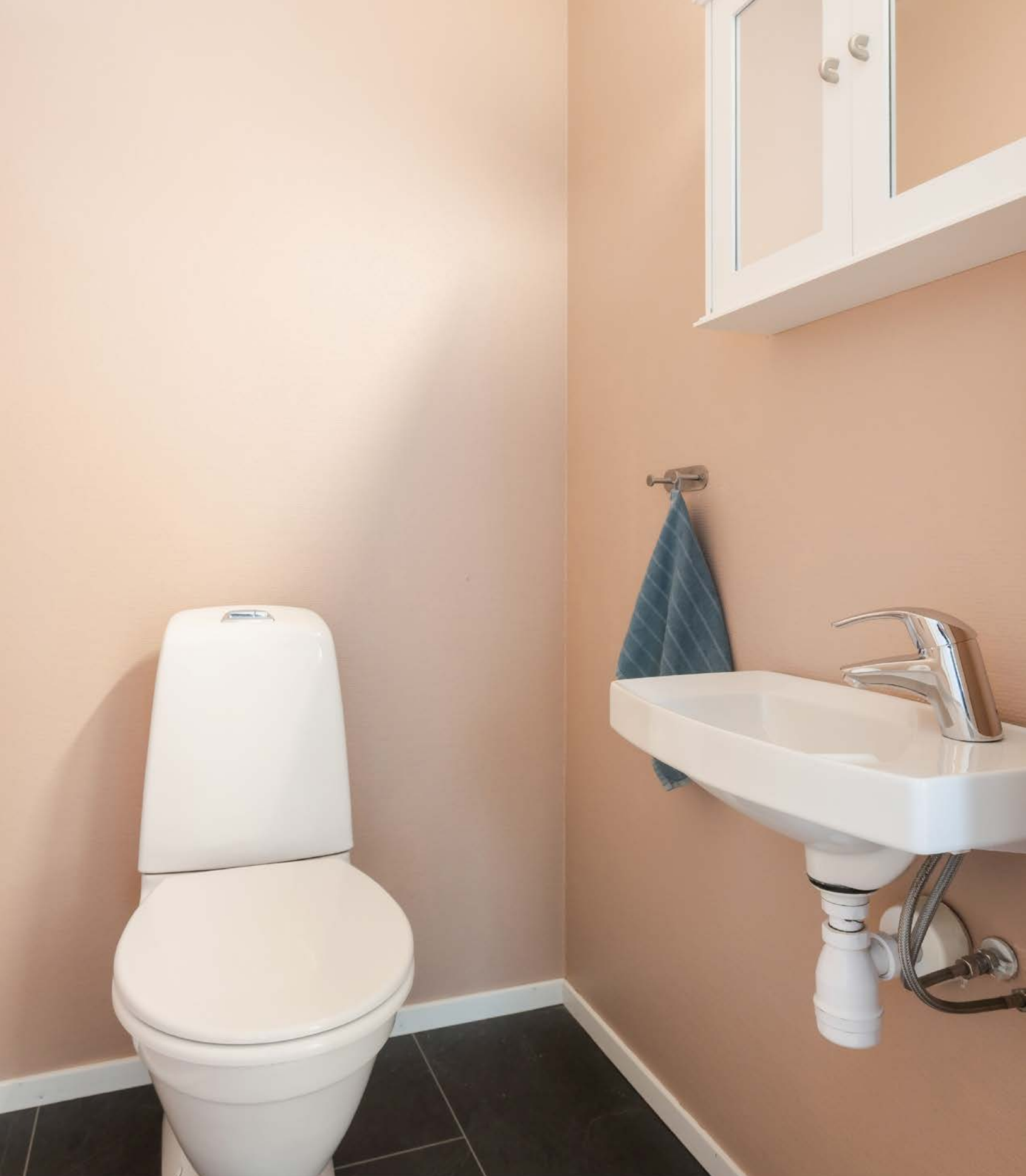
Separat toalettrom med gulvmontert toalett og servant på vegg.
