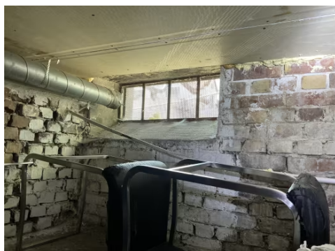
Bod er luftet med gitter i vindu.
