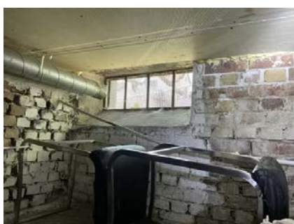
Bod er luftet med gitter i vindu.
