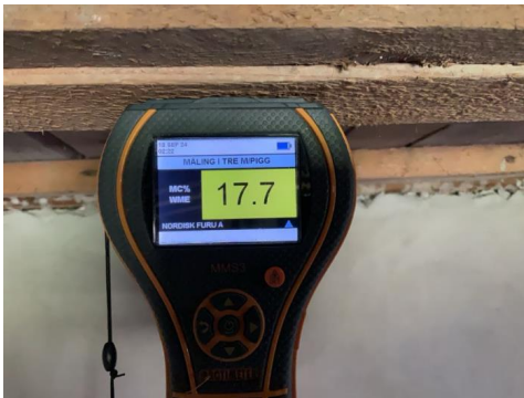
Fuktmåling i bjelker i kjelleren.
