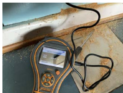
Fuktmåling i konstruksjonen.
