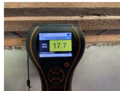
Fuktmåling i bjelker i kjelleren.
