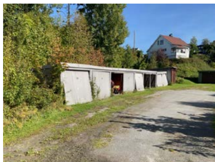
Garasjer i felles rekkeanlegg.
