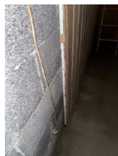
Bruk av plastisolasjon bak panel
