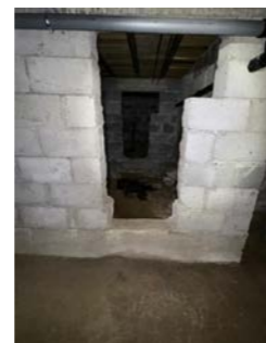
Krypkjeller under opprinnelig del.
