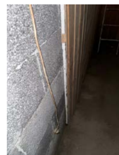
Bruk av plastisolasjon bak panel
