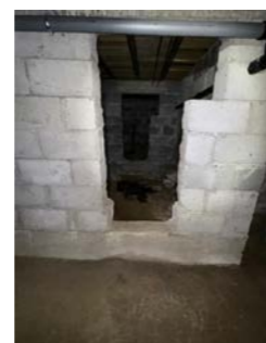
Krypkjeller under opprinnelig del.
