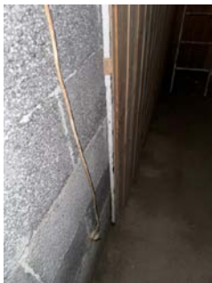
Bruk av plastisolasjon bak panel
