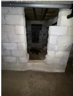
Krypkjeller under opprinnelig del.
