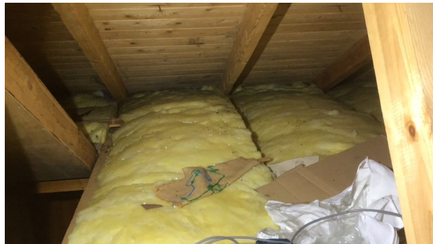
Isolasjon mot yttertak
