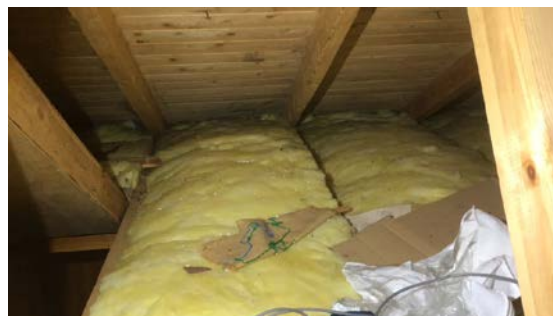
Isolasjon mot yttertak
