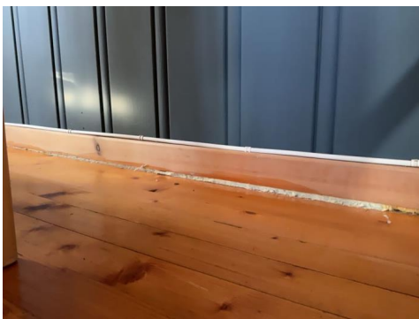
Glipper mellom gulv/gulvlist
