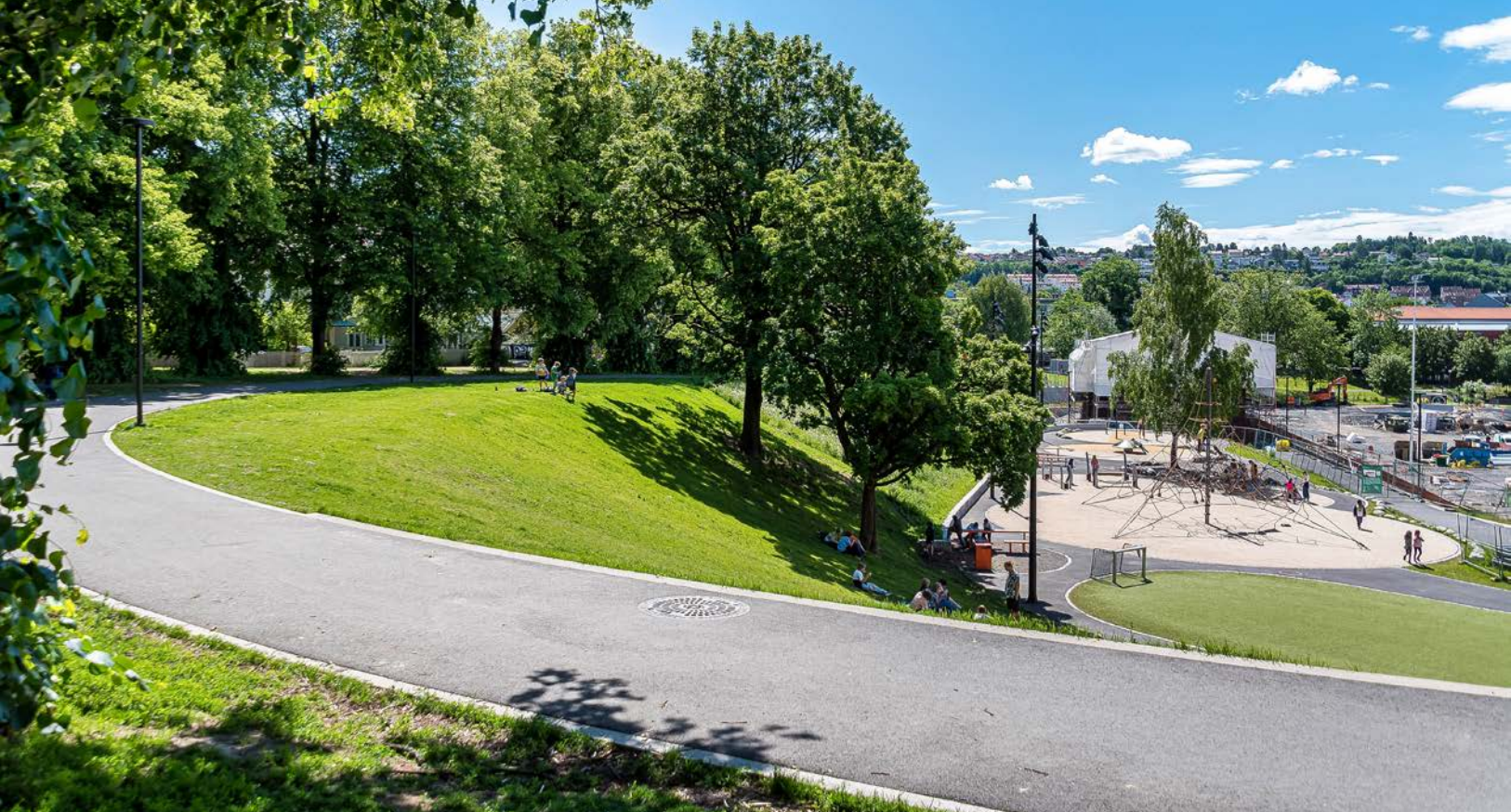
Jordalparkenanlegg har vært gjennom omfattende rehabilitering. Ny skatepark, fotballbane og rehabilitert klubbhus sto ferdig i løpet av 2023.
