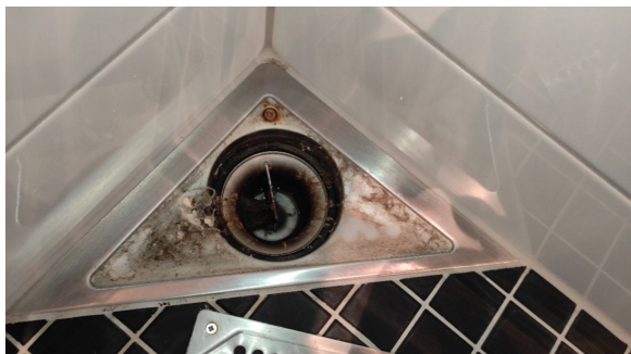
Kontroll av sluk.
