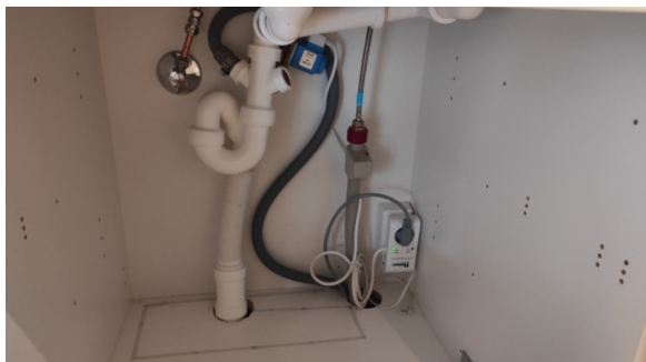
Kontroll av røropplegg.
