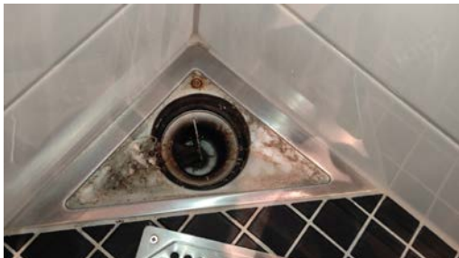
Kontroll av sluk.
