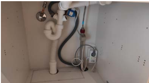
Kontroll av røropplegg.
