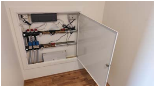
Kontroll av forderlerskap.
