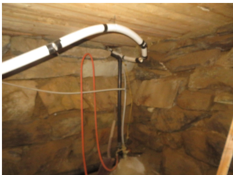
Del av blindkjeller under opprinnelig del.
