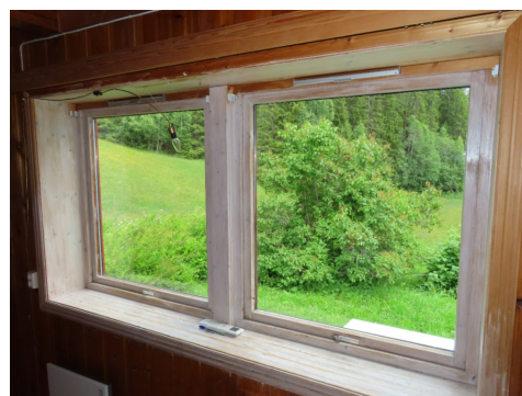
Energivinduer på kjøkken. Luftespalte i overkarm.
