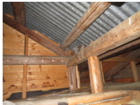
Del av kaldloft inspisert via luke i himling inne på klev. Opprinnelig tekking uten undertak.
