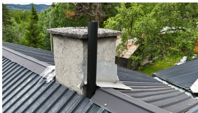
Ufullstendig pipebeslag - uttetheter.
