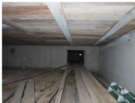
Del av luftet krypkjeller under tilbygd del.
