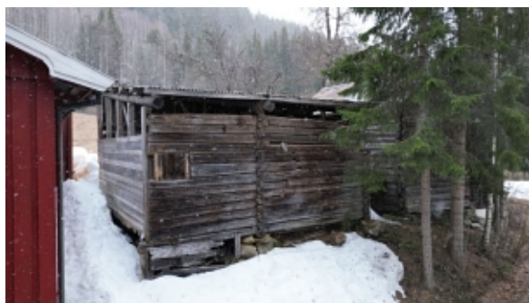
Uthus Merk bygget enklere stand og behov for ettersyn og vedlikehold.
