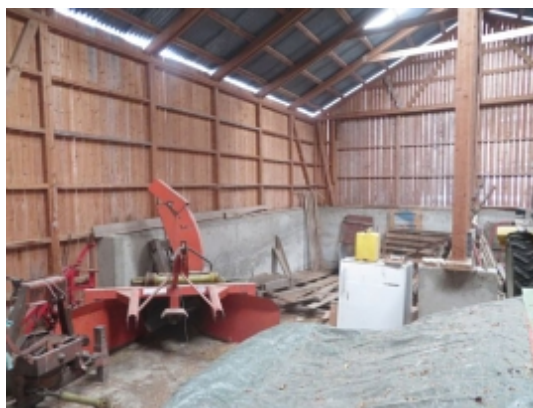
Driftsbygning Låvedelen med plansilo samt støpte gulv i hoveddel for redskapsoppstilling mm.
