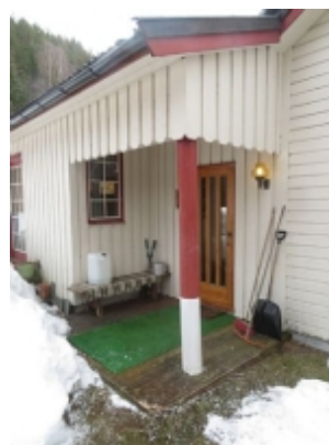
Inngangsparti. Overbygd inngangsparti.
