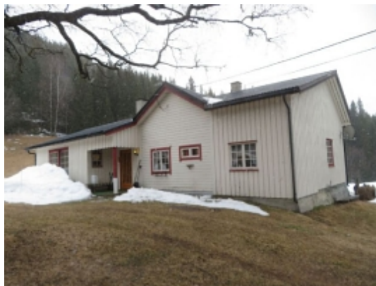
Utvendige fasader. Dels liggende, dels stående kledning. Påstøp på natursteinsmur til opprinnelig del.
