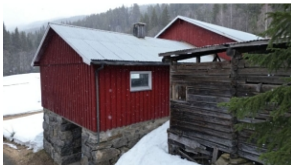
Driftsbygning Fjøset er bygd nytt på eksisterende natursteinsmur fra 1932.
