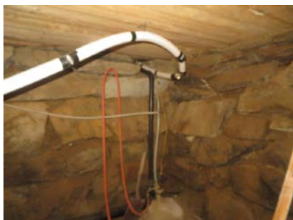
Del av blindkjeller under opprinnelig del.
