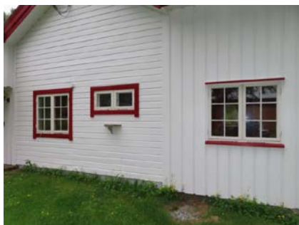
Vinduer på inngangssiden. Eldre, enklere vinduer.
