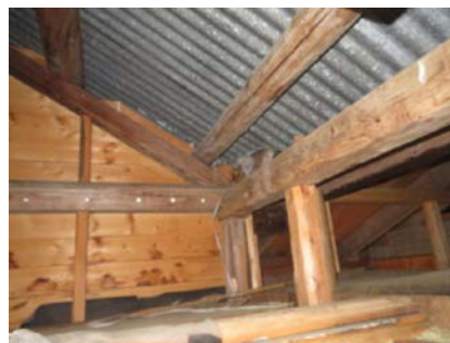
Del av kaldloft inspisert via luke i himling inne på kleve. Opprinnelig tekking uten undertak.
