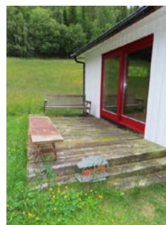
Åpen markterrasse ut for stue. Merk at denne er etablert av jernbanesviller lagt direkte til terrenget.
