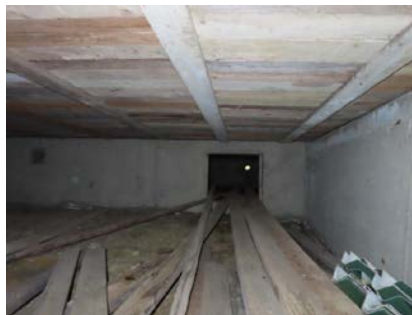
Del av luftet krypkjeller under tilbygd del.
