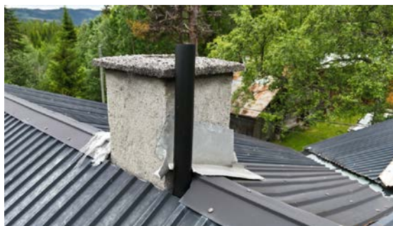
Ufullstendig pipebeslag - utettheter.
