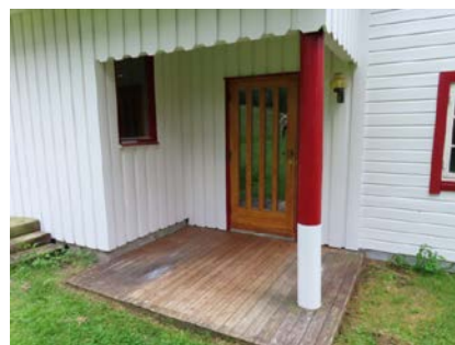
Overbygd inngangsparti med spaltegulv.
