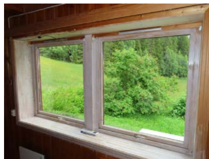
Energivinduer på kjøkken. Luftespalte i overkarm.
