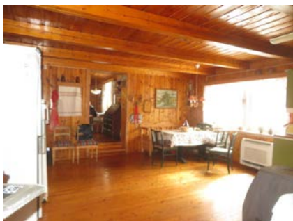
Del av innvendige overflater. Stue med tregulv - trepanel til vegger og i himlinger. Merk slitasje i stuegulvene.
