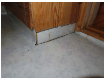
Utett gulv på vaskerom.
